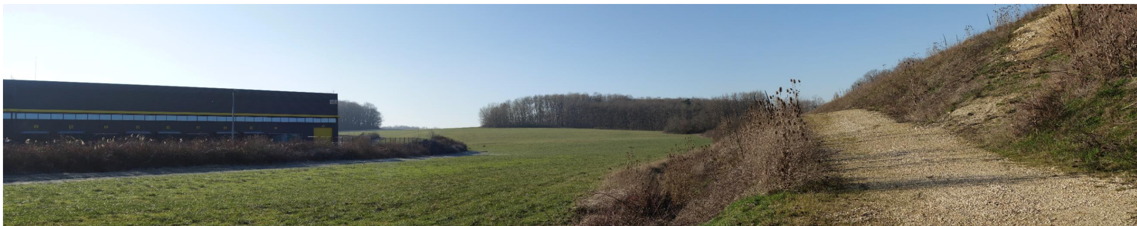
Photo 23 : Depuis l'entrée du site/la départementale 619
