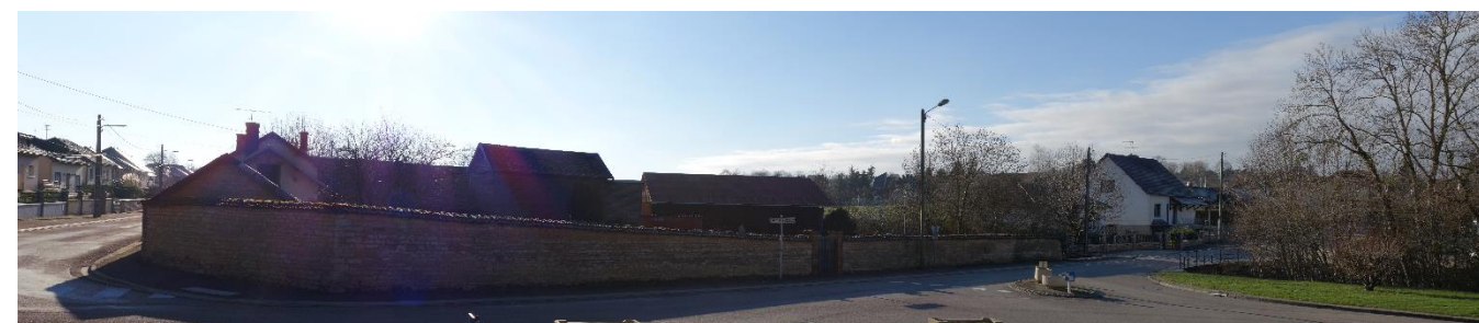
Photo 40 : Vue vers le site depuis le parc du Château
